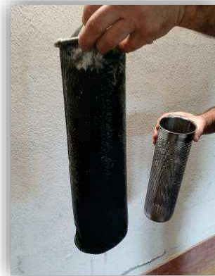
Sostituzione calza filtrante
